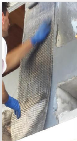
rinforzo pilastri e travi con fibra PBO
