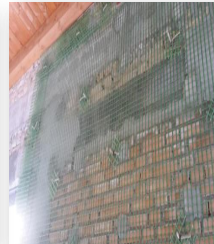
rinforzo_muratura_con_rete_in_fibra_GFRP
