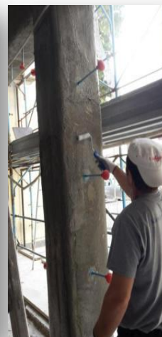
rinforzo pilastri e travi con fibra PBO
