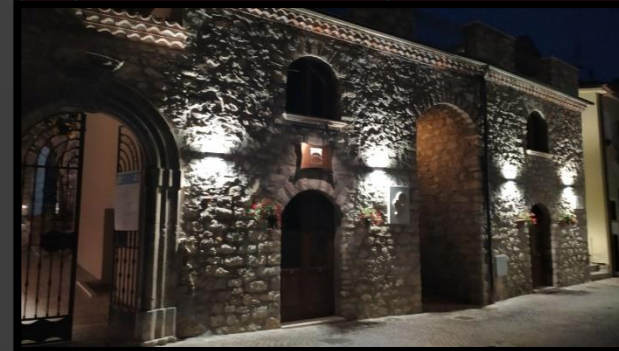
Ripristino facciata in pietra
