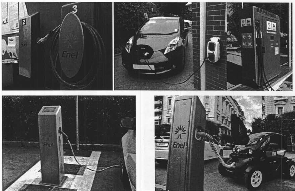
Figura 158. Esempi di infrastrutture di ricarica elettrica.
