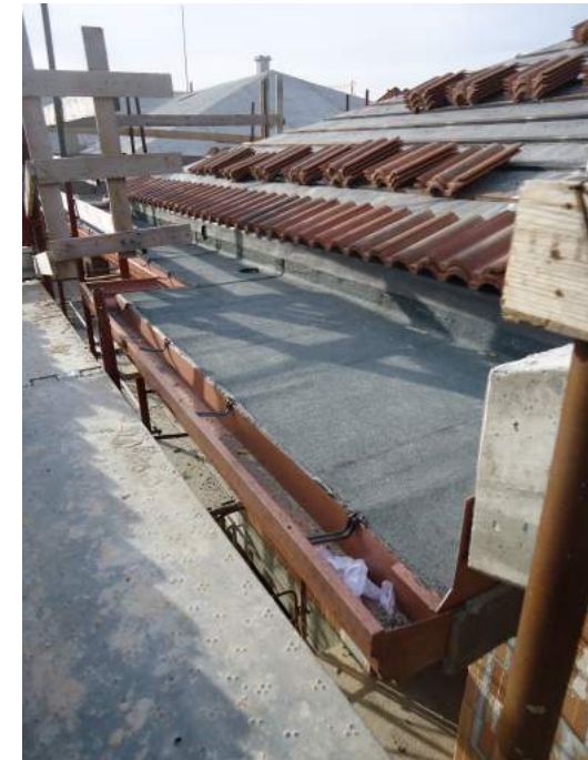
Membrana traspirante ed impermeabile all'acqua (Divoroll Universal S della Wierer)
