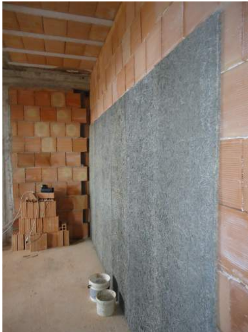
Pannello in fibra di legno mineralizzata per coibentazione e isolamento acustico
