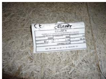
Pannello in fibra di legno mineralizzata per coibentazione e isolamento acustico
